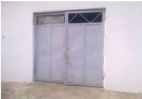
شکل ۳-۵۱- ارتفاع پایین درب و باز شدن به بیرون
