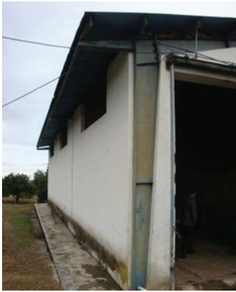
شکل ۳-۴۱- نمونه‌ای از وضعیت لبه‌های سقف و موقعیت پنجره‌ها (کترا)
