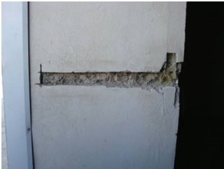
شکل ۳-۴۲- استفاده از مواد عایق در ساخت دیوارهای انبار
