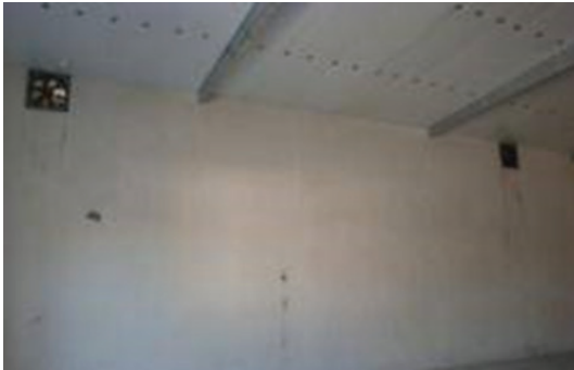
شکل ۳-۴۳- عایق بندی سقف انبار
